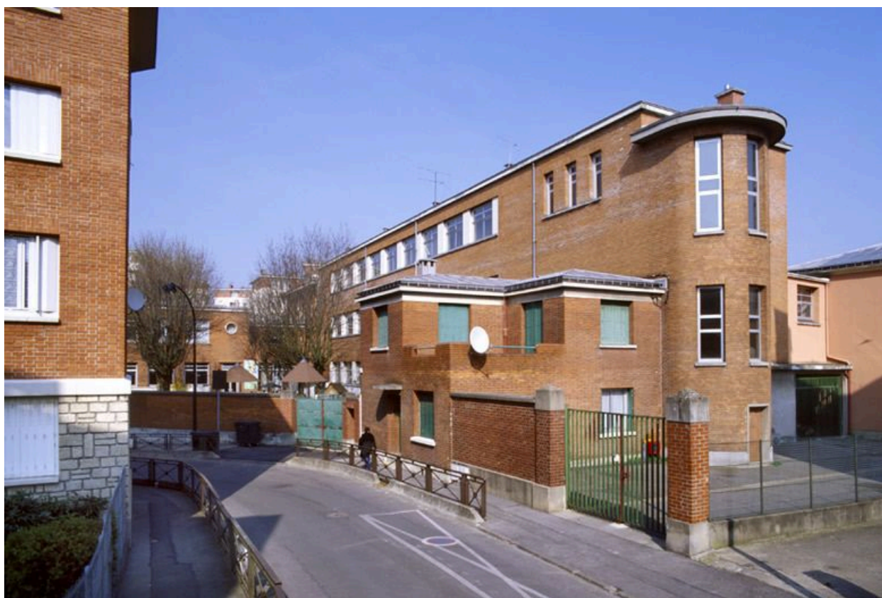
Vue du groupe scolaire Albert-Thomas, rue Charles-Fourier.
