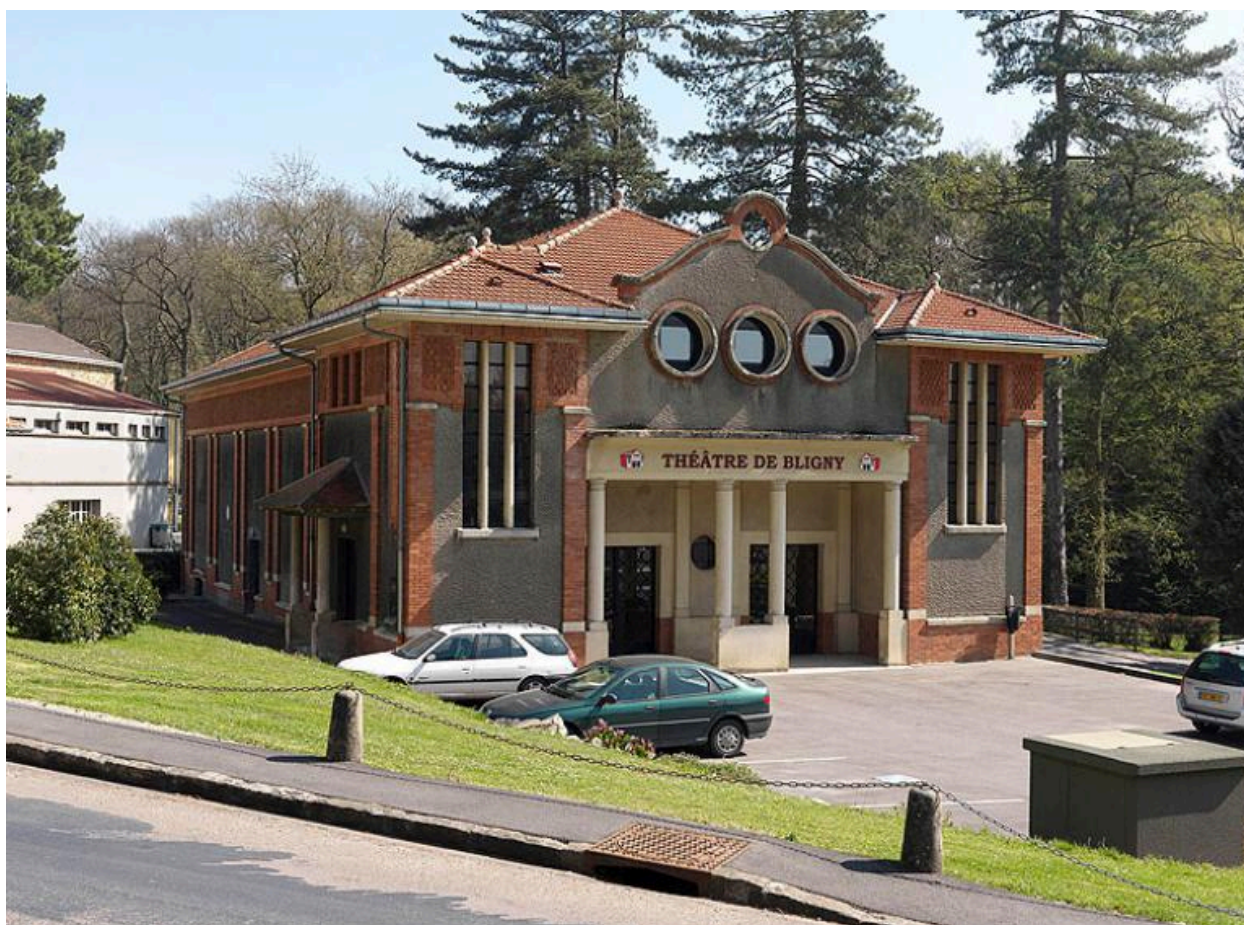
Bâtiment abritant le théâtre du sanatorium, élévation antérieure, vue générale.
