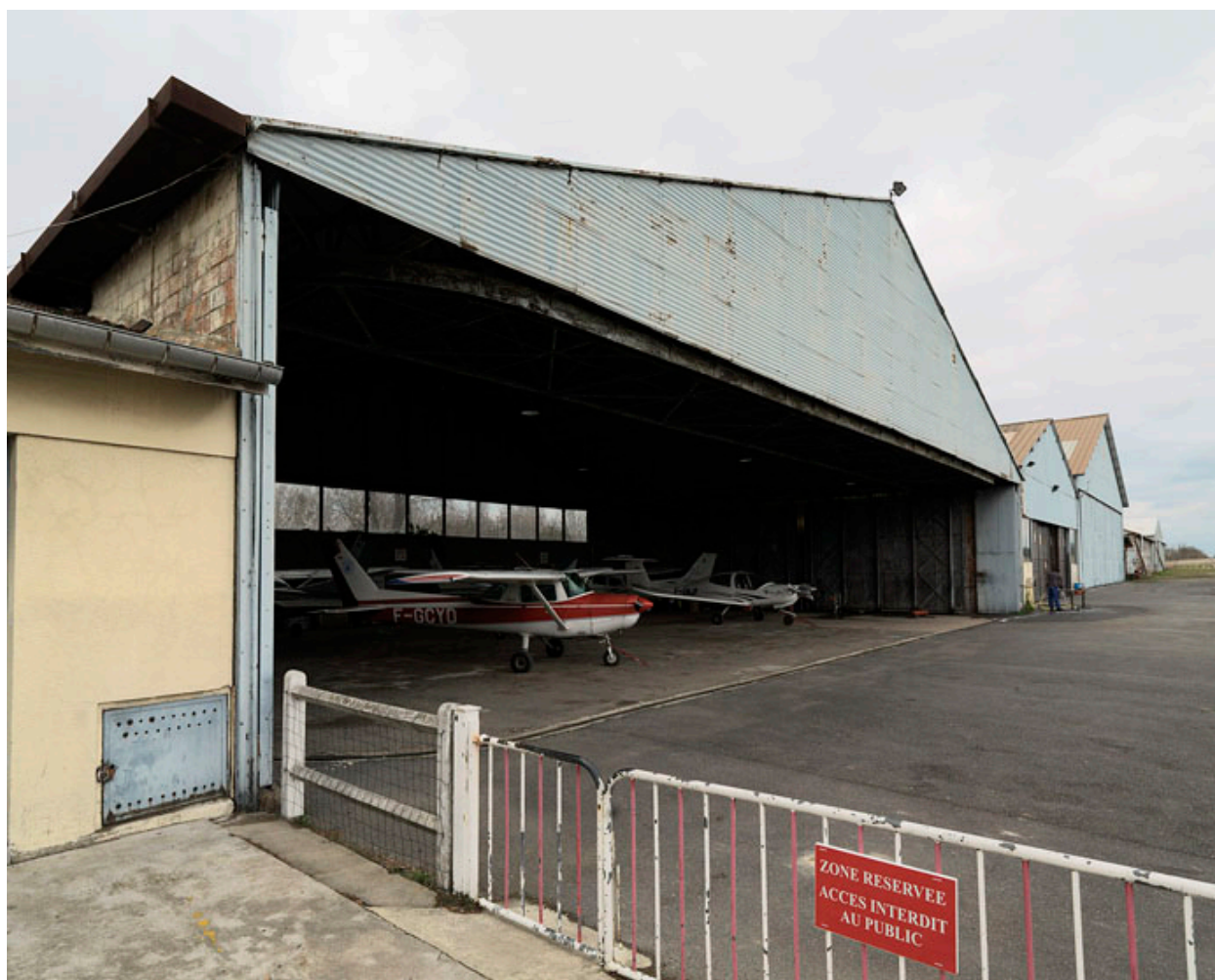
Détail de l'un des hangars.
