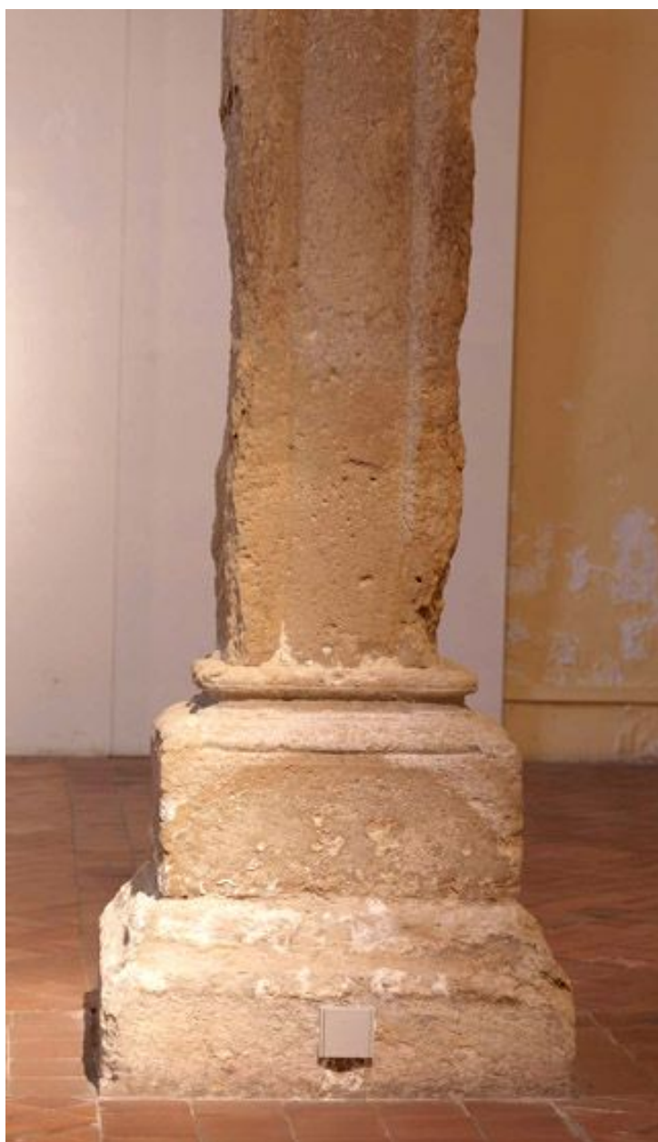
La salle basse occidentale : détail d'une base de pilier, très érodé.
