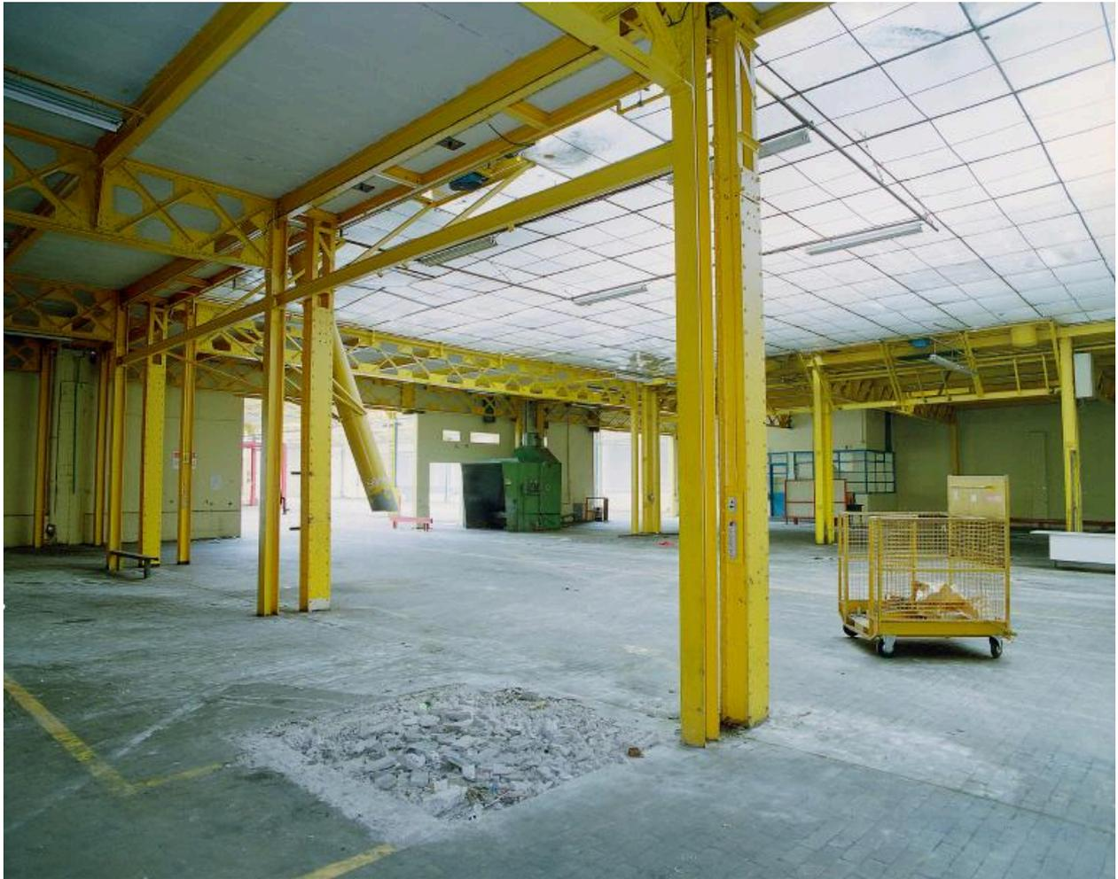
Intérieur de l'ancien atelier de chaudronnerie de l'usine Rateau, devenu magasin de stockage des pièces détachées puis atelier de montage de l'usine Guitel-Etienne. Le "plancher caoutchouc" a été mise en place vers 1968-1970 afin d'augmenter la capacité de stockage du magasin pièces détachées. A gauche, le conduit en PVC permettait d'acheminer les pièces en plastique depuis le premier étage jusqu'au rez-de-chaussée. Au fond, une cabine de peinture.
