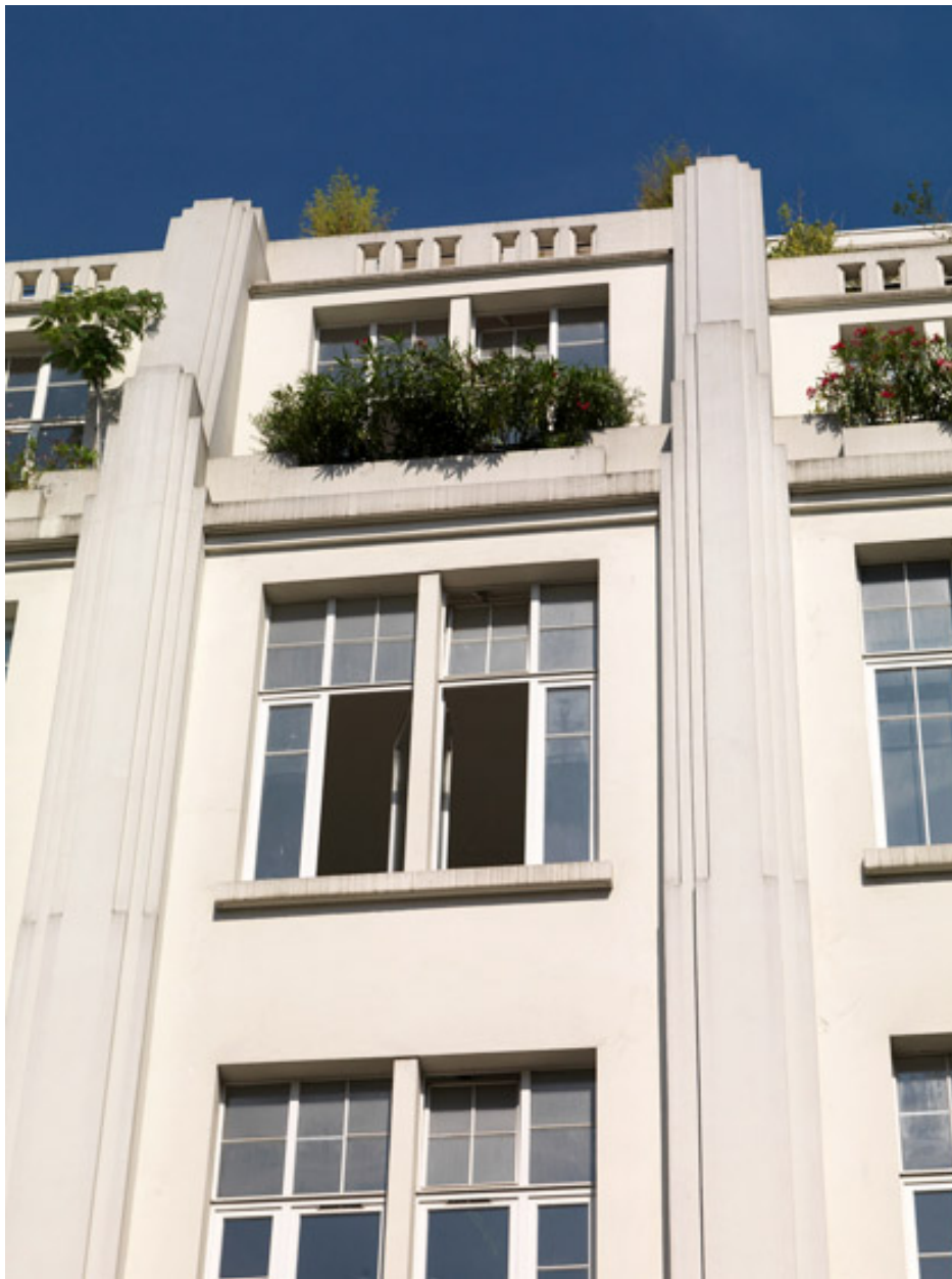
Immeubles-ateliers d'artistes, 26, rue des Plantes (et 29, rue Hippolyte-Maindron) : détail des derniers étages d'une travée de la façade sur rue.
