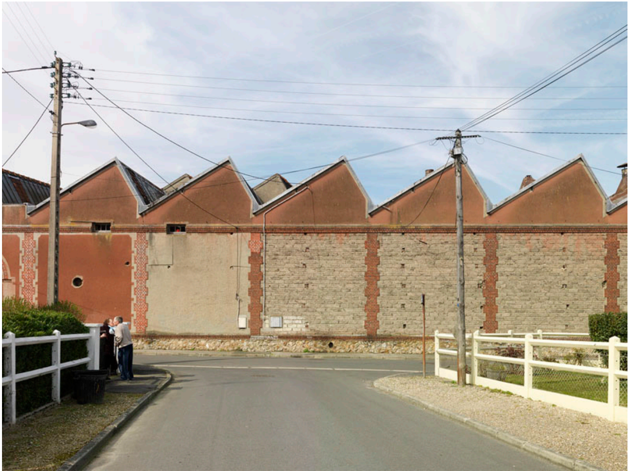
Asnières-sur-Oise. Sheds de l'ancienne usine Vulli, vus depuis la zone pavillonnaire. ...une embrassade.
