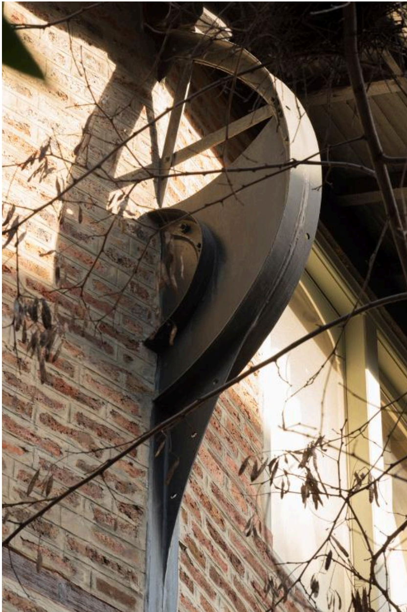
Détail d'un élément de la charpente métallique de la Rotonde
