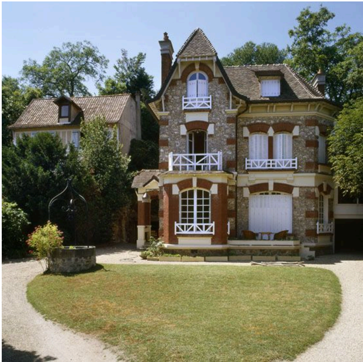
Andrésey. Façade principale d'une villa, 6 quai de l'Ecluse.
