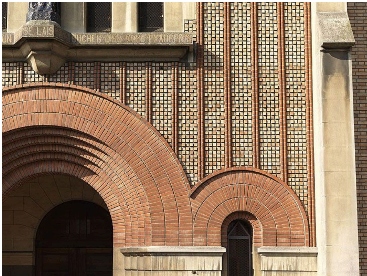
93, Bagnolez, église paroissiale Notre-Dame-de-Pontmain, rue Robespierre. Détail de l'appareil de brique de la facade pignon de la nef.
