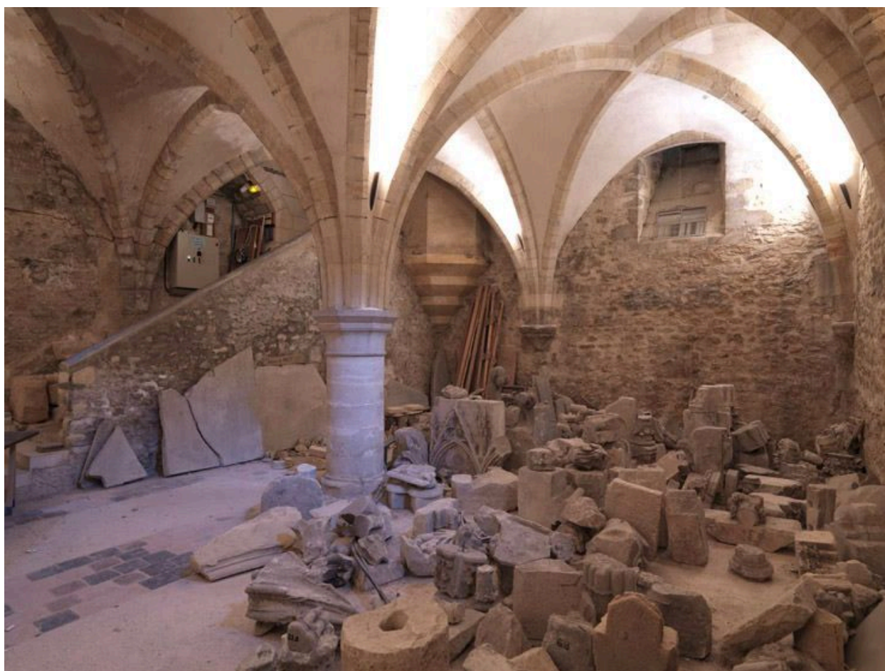
La salle voûtée du sous-sol : partie sud, avec l'escalier d'accès au fond.
