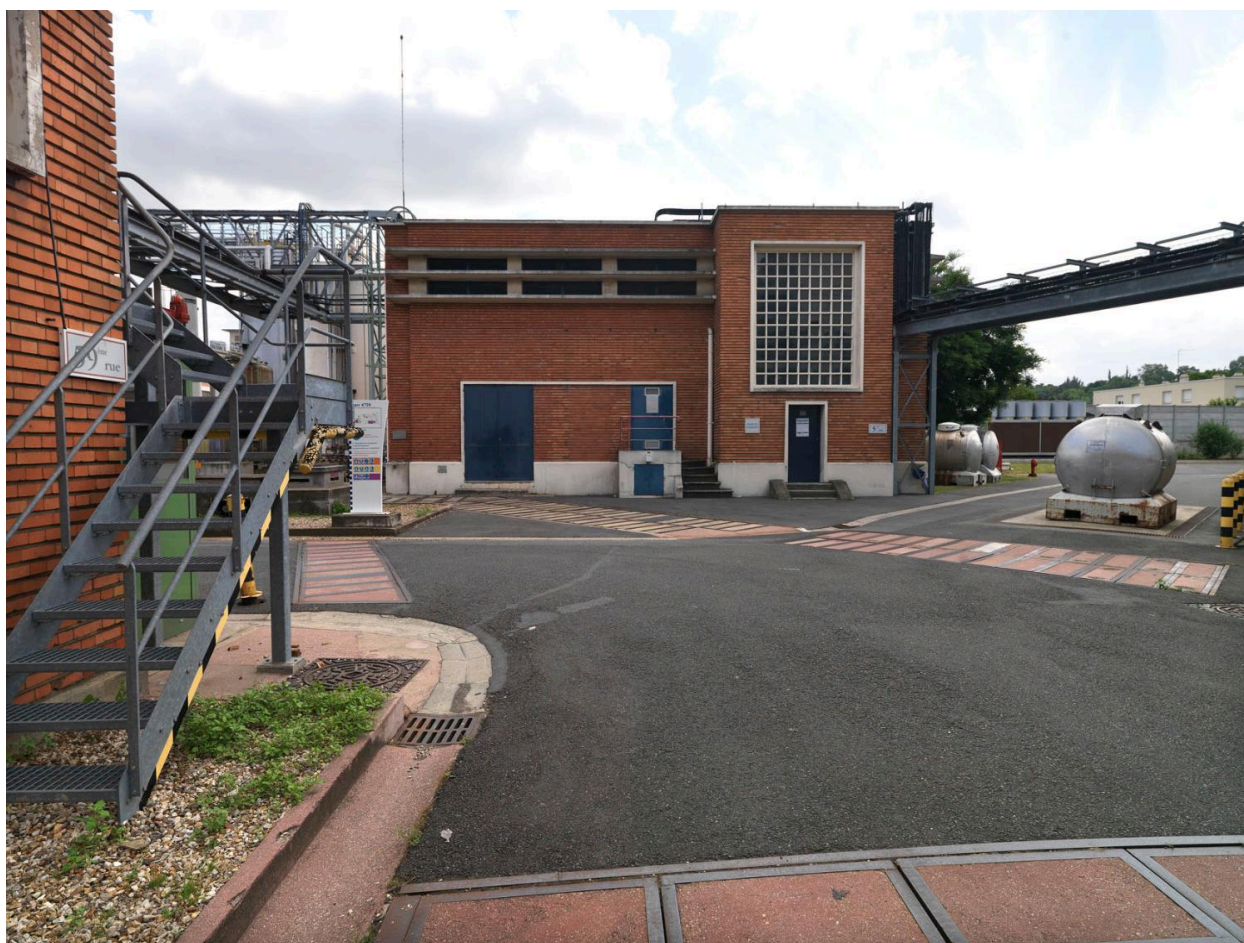
Site Sanofi. Vue des liaisons entre bâtiments.
