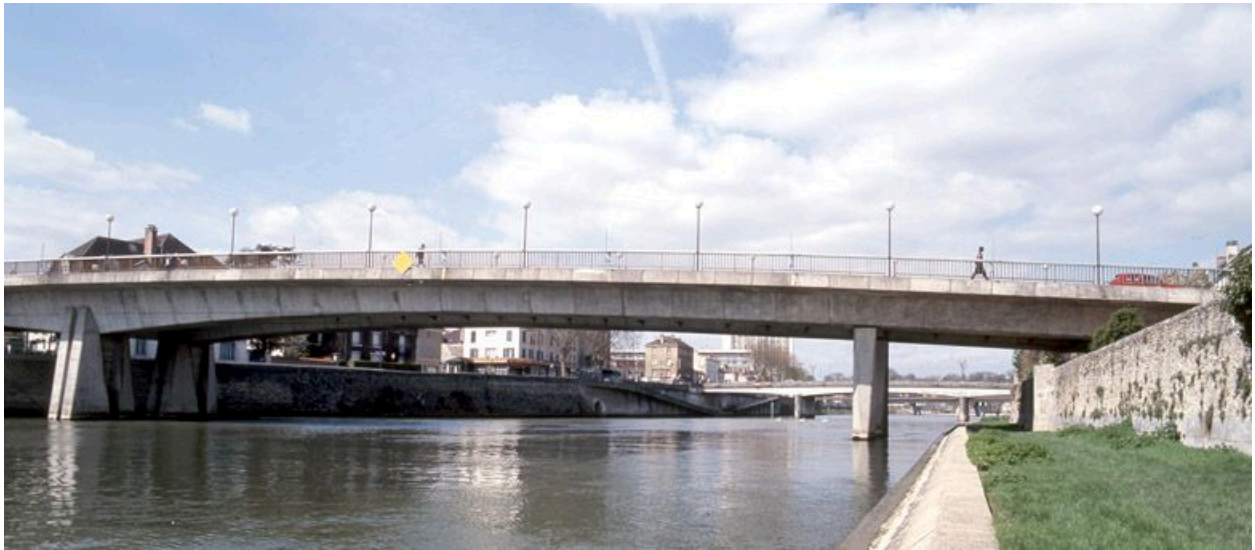
Le pont Notre-Dame vu de l'amont, depuis l'île Saint-Etienne.
