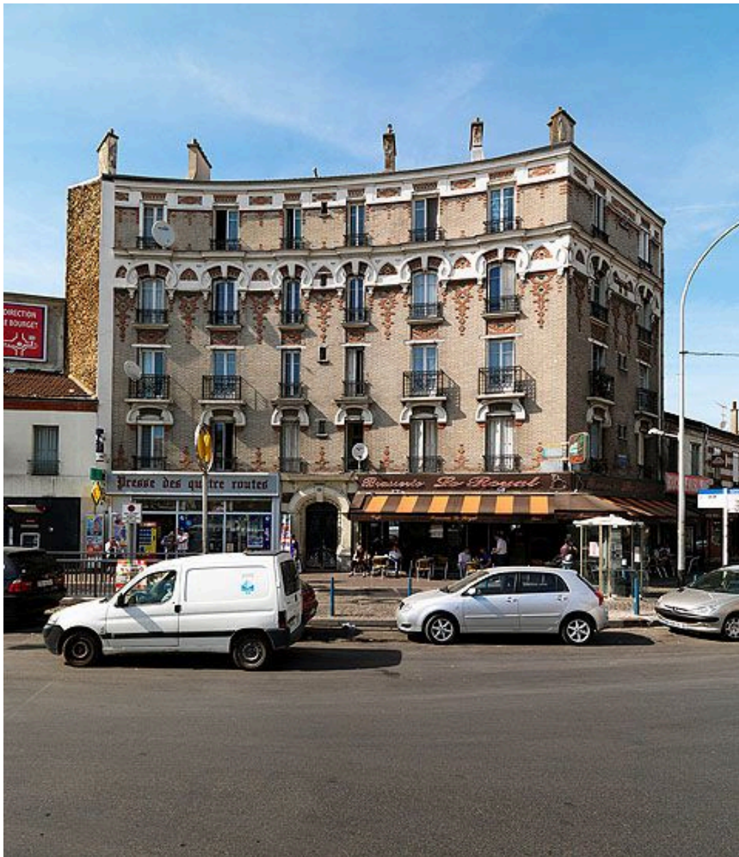
93, La Courneuve, immeuble, place du 8-mai. Vue d'ensemble de la façade.
