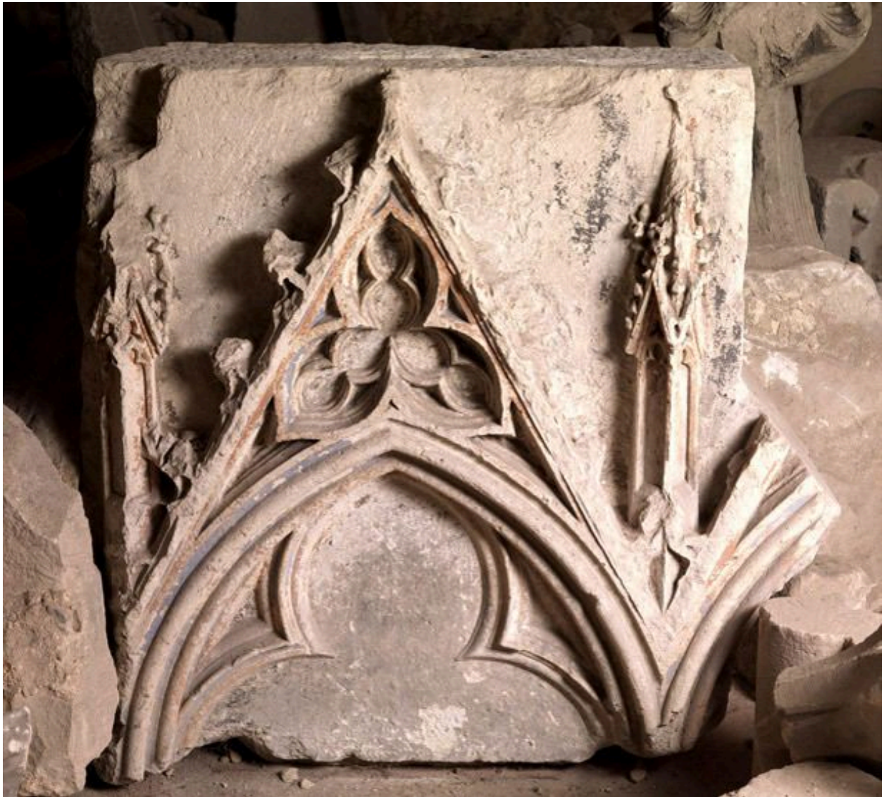
Arcature sans n° d'inventaire (h = 102 cm, l = 100 cm, pr = 41 cm) : vue de face. Ce bloc sculpté provient de la piscine d'une chapelle rayonnante, déposée lors des travaux de restauration de Danjoy (1861). Autre vue : 20087700665NUC4A.
