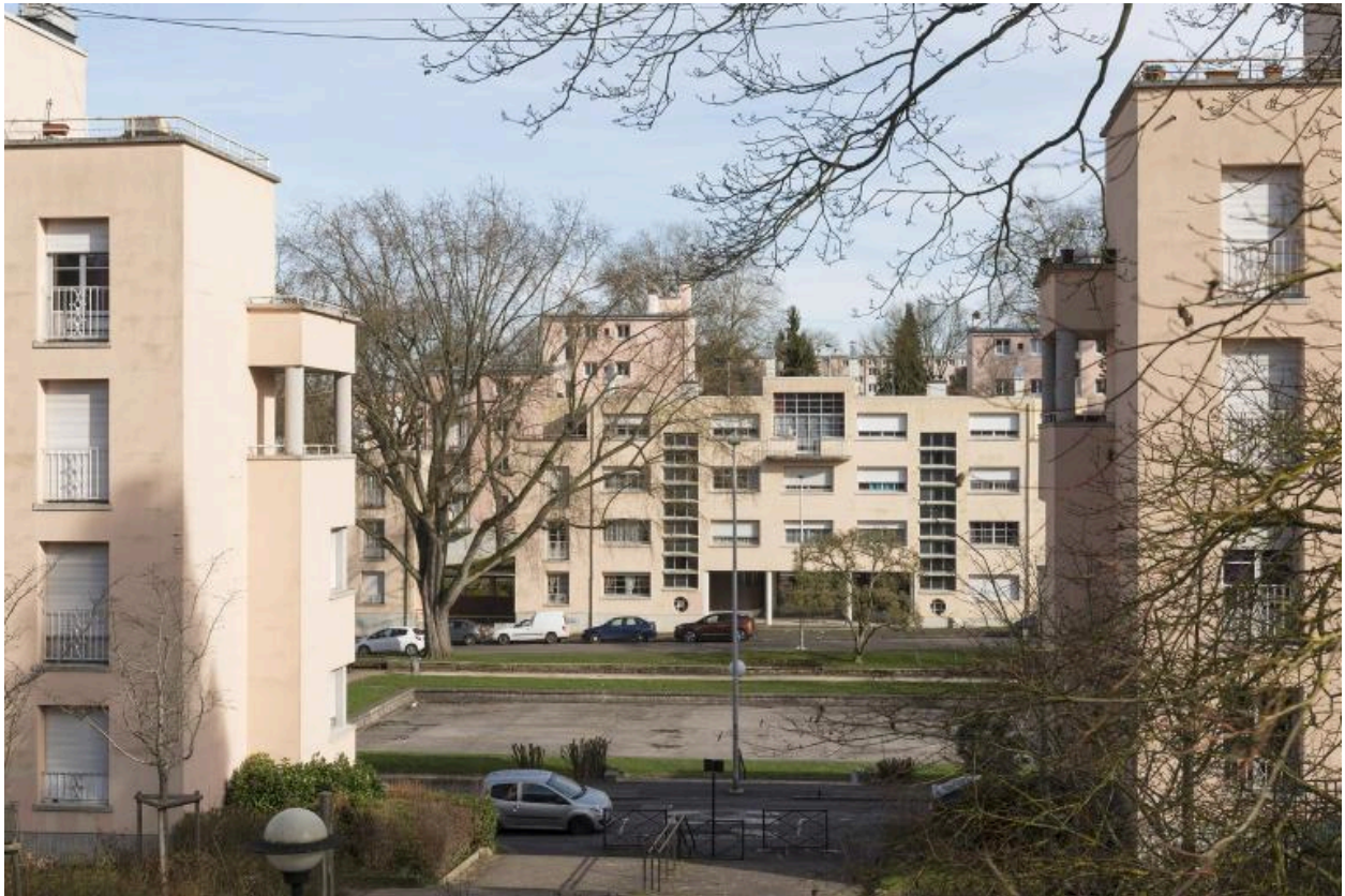
Vue de la Cité de la Butte rouge percée vers la place François-Simiand
