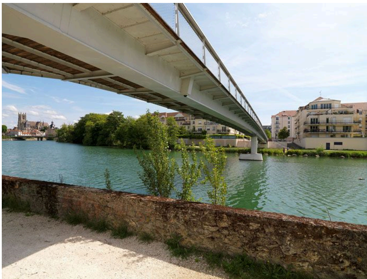
Le tablier de la passerelle, vu depuis la rive ouest.
