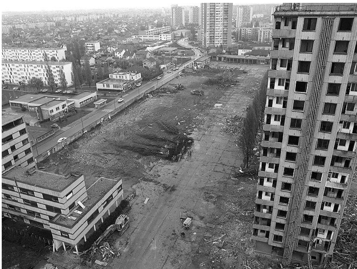
A droite Tour 2, façade ouest. Campagne photographique, lors de la destruction du bâtiment en 1976.
