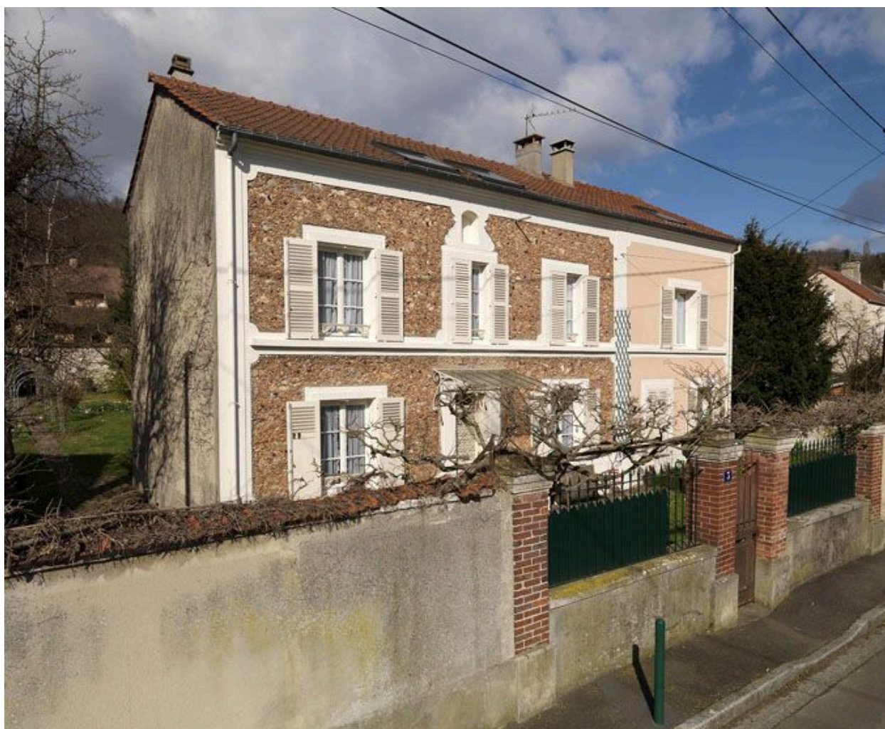
Chanteloup-les-Vignes. Vue d'ensemble de la façade principale d'une villa, 3 rue Pauline-Soyer.
