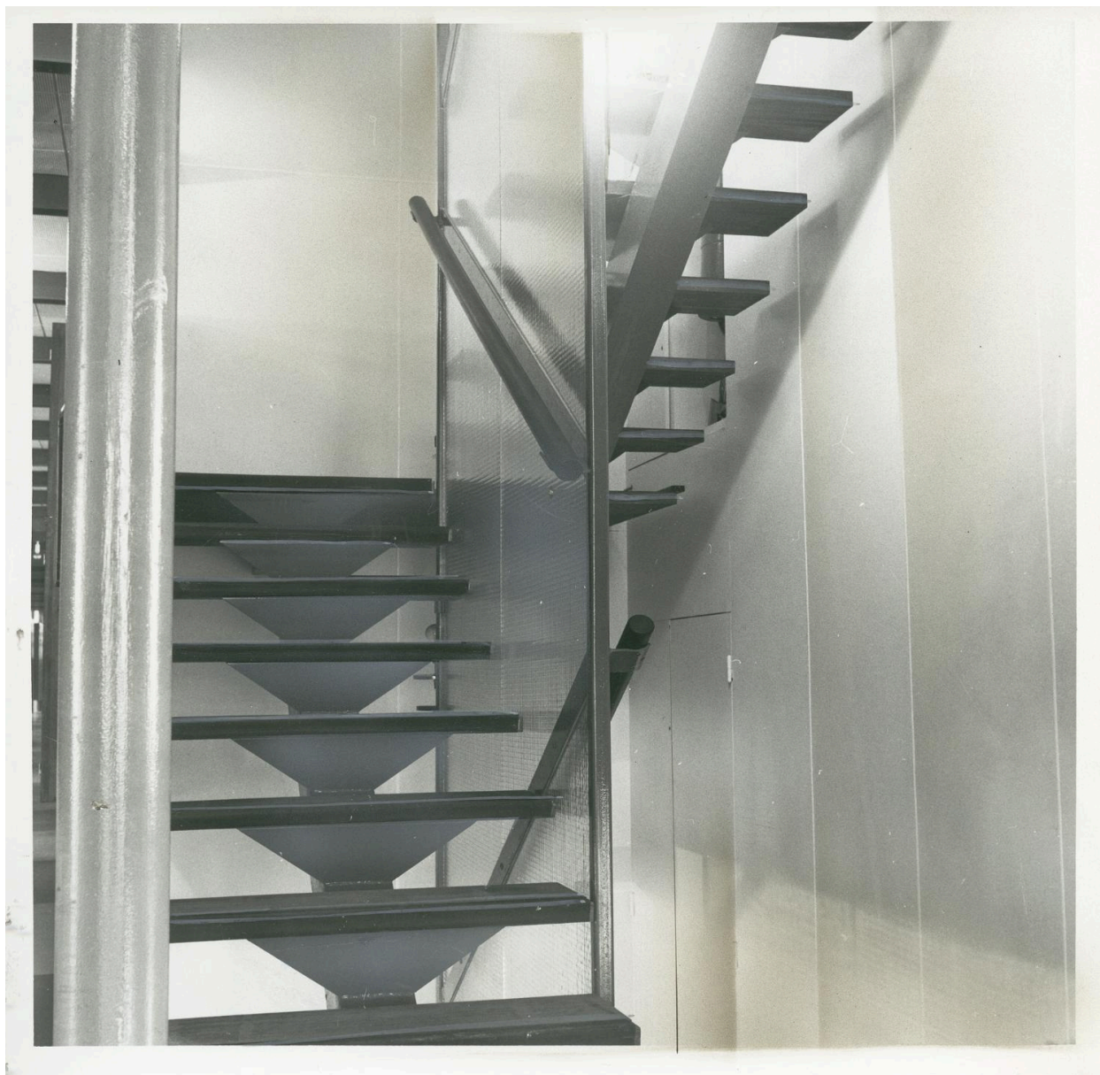
1961, le siège d'Air France ou bâtiment 363, escalier secondaire.
