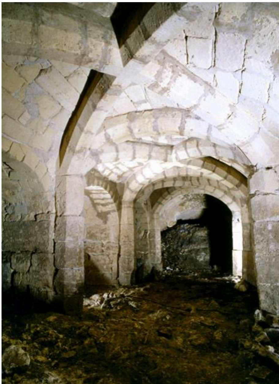
Cave de l'hôtel-restaurant Aux caveaux du vieux monastère, 75 rue Louis Talamoni. Autre vue actuelle du premier niveau de cave.
