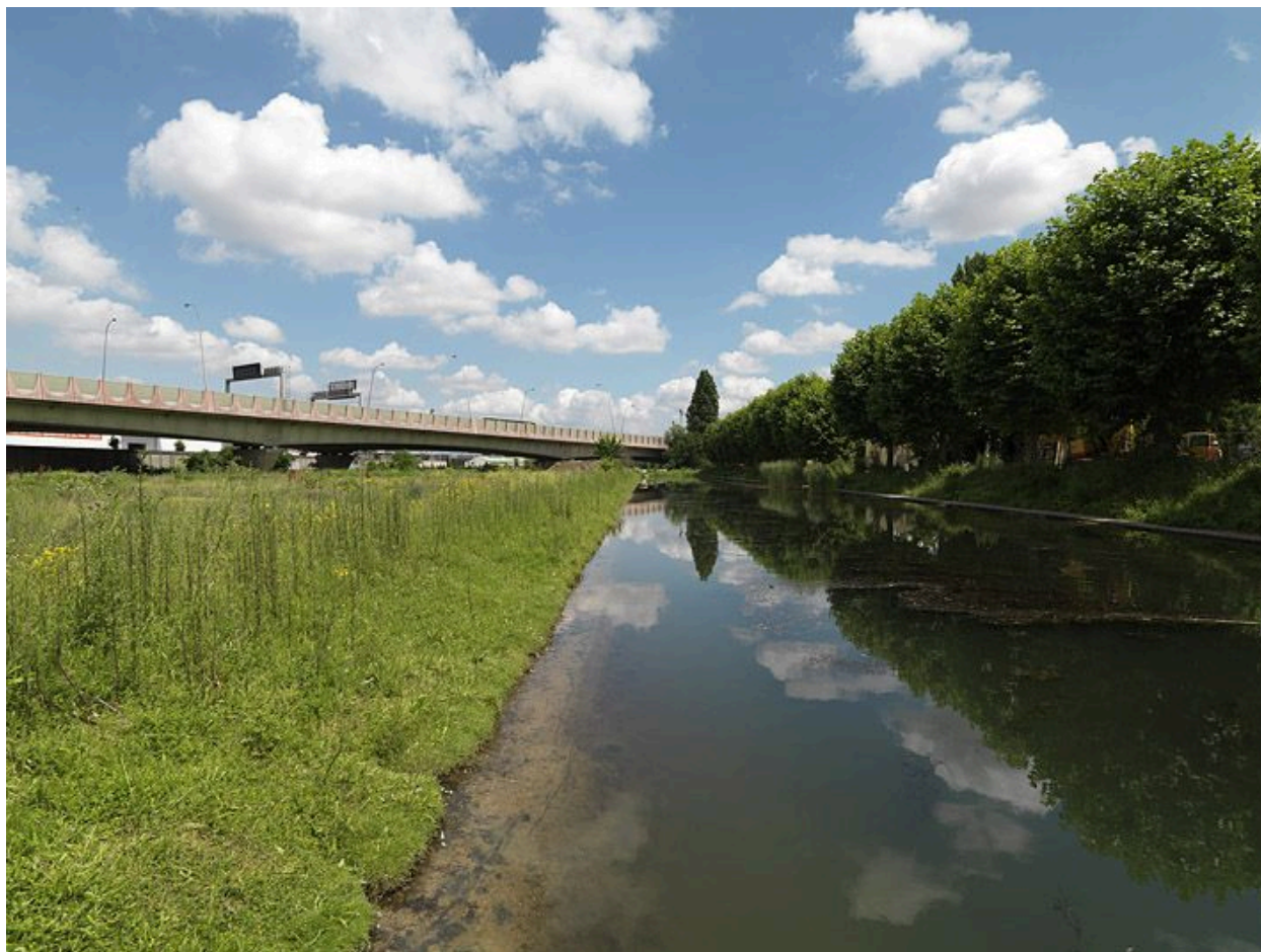
Choisy-le-Roi, Alfortville, Vitry-sur-Seine. Pont de Choisy de l'A86. Vue du viaduc enjambant la darse d'Alfortville.
