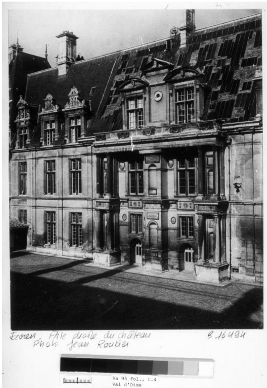
La façade sur cour de l'aile nord, photographie ancienne, BnF, Estampes, Topo Va Val d'Oise, t. 4, B 16494.
