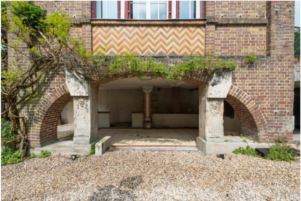
Soubassement de la façade principale de l'atelier
