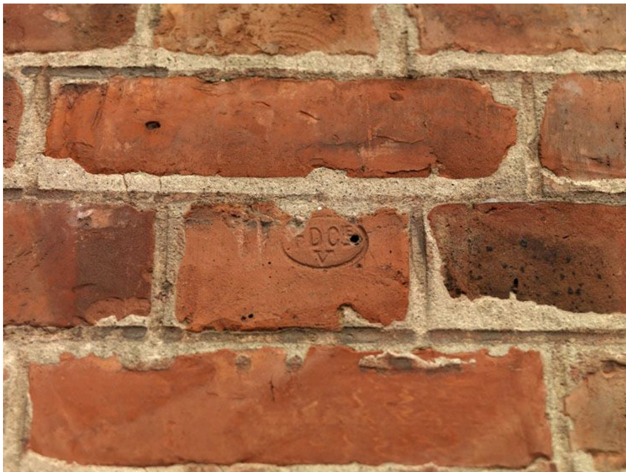
92, Sceaux, lycée Lakanal, 3-7 avenue du Président-Franklin-Roosevelt. Infirmerie : mur de briques estampillées.
