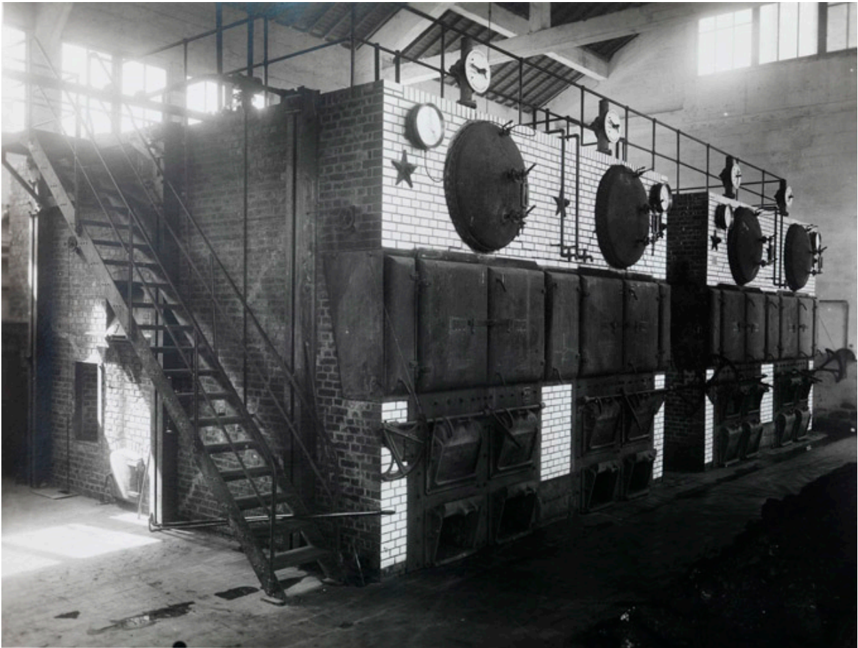
Les chaudières. (Archives de l'Assistance publique, 3 Fi 3/20)
