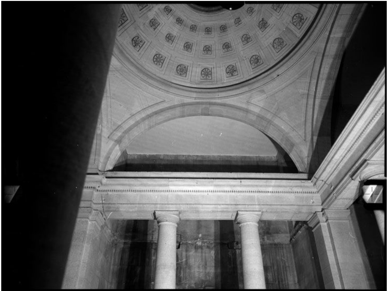
Architrave dans le choeur.
