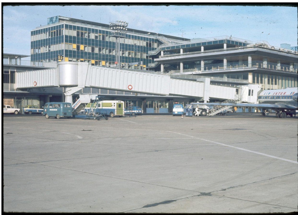
1970, les premières passerelles d'embarquement de l'aéroport d'Orly.
