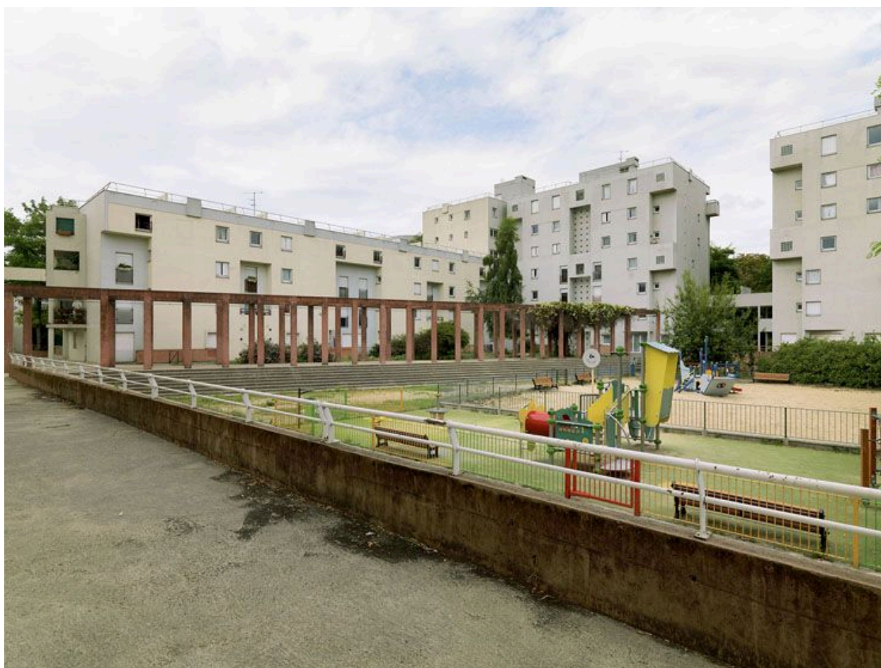
Cité Pablo Neruda. Vue d'ensemble de la cité réalisée en 1980 par Paul Chemetov (Atelier d'urbanisme et d'architecture), depuis le square intérieur.
