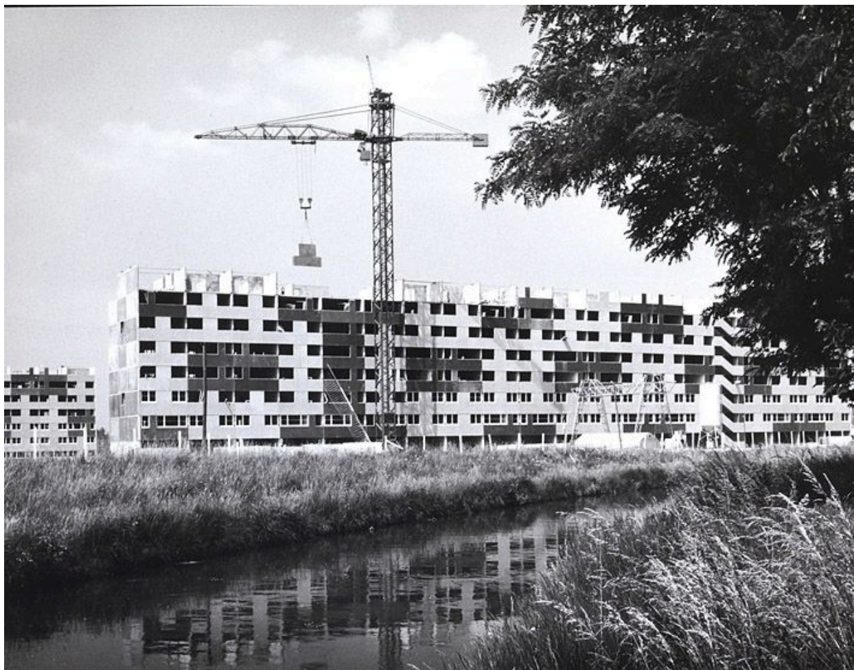
Construction des barres et des tours. (Cité de l'architecture et du patrimoine. fonds Ginsberg 100 boîte 3006)
