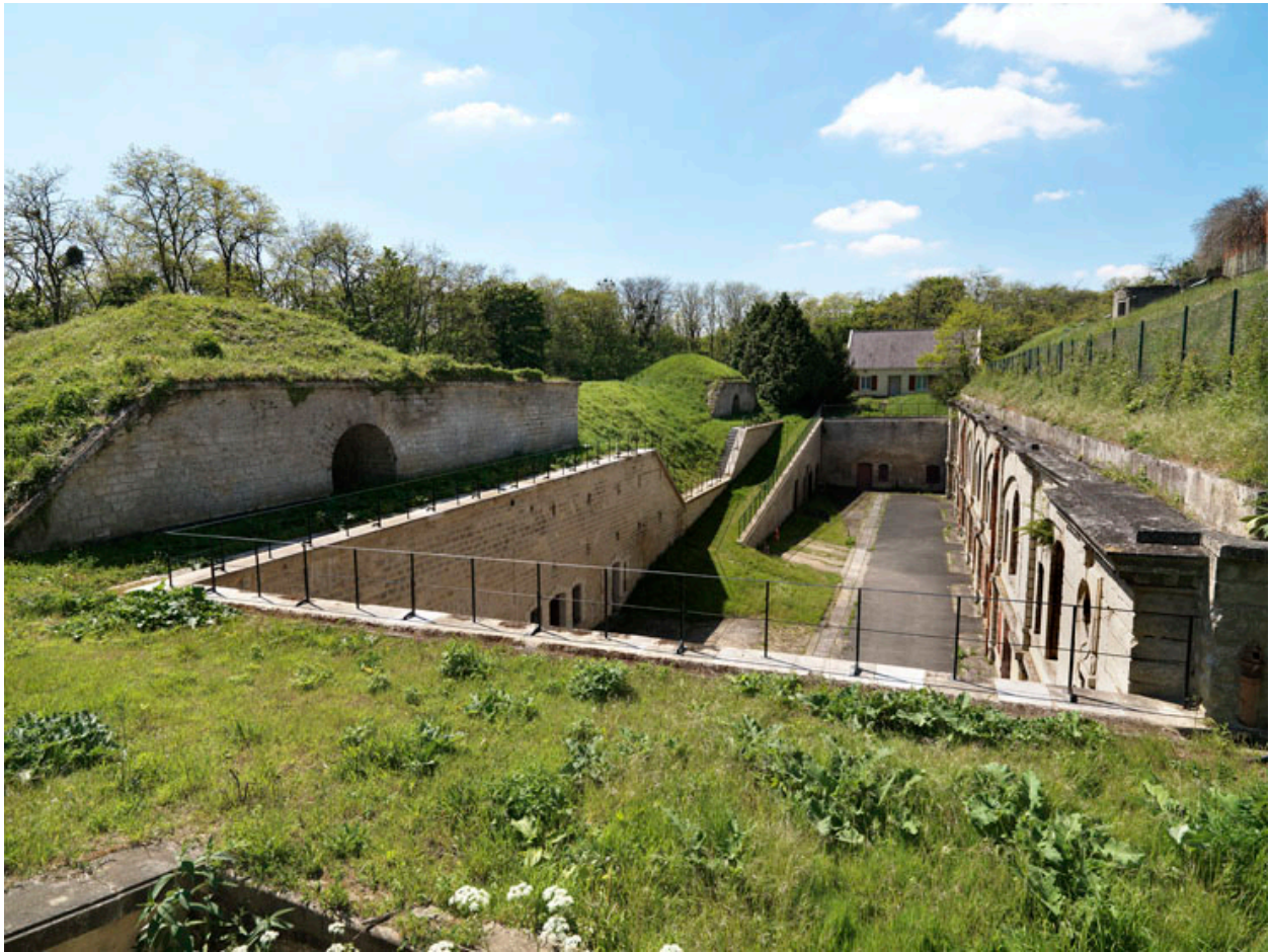
Vue du sommet des bâtiments, depuis l'est.
