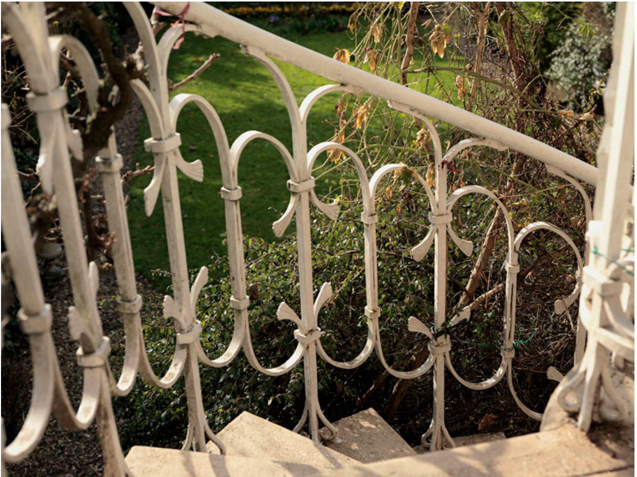
Détail de la balustre en ferronnerie de l'escalier extérieur conduisant du jardin au rez-de-chaussée surélevé, probablement dessiné par le ferronnier d'art Emile Robert.
