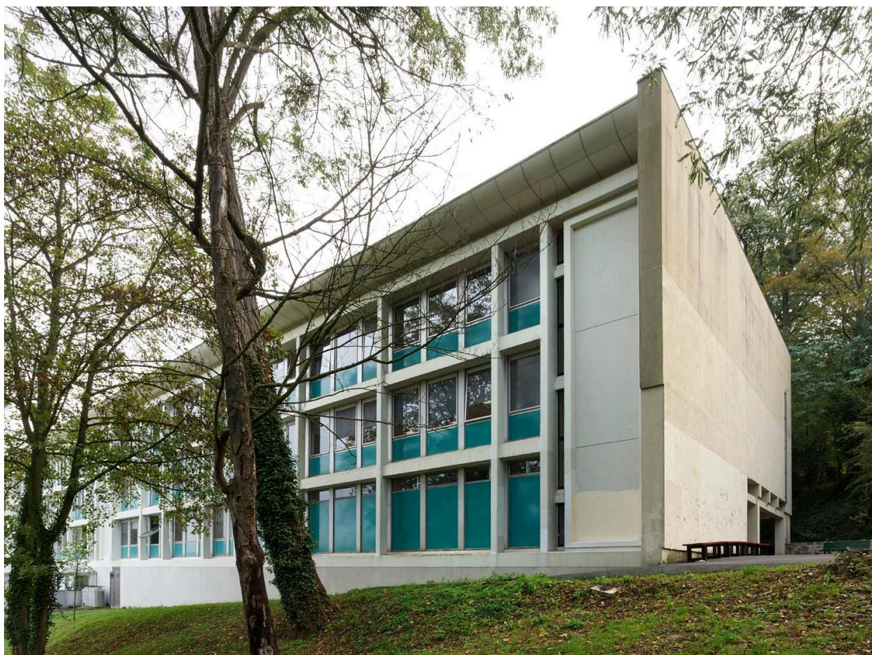
L'actuel bâtiment du lycée. Les façades se développent sur trois niveaux de manière très régulière, avec un entraxe de 5,25 m, résultat de la combinaison de 3 x 1,75 m entre chaque poteau porteur de la structure en béton armé.
