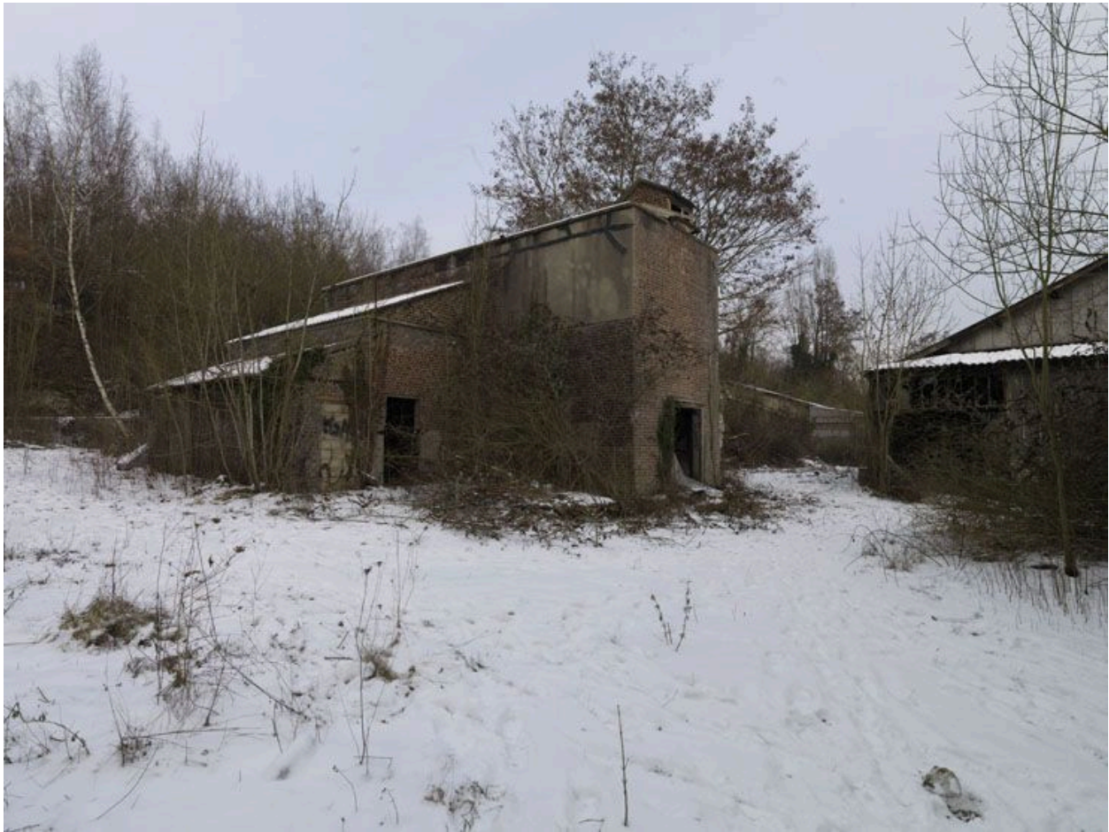
Follainville-Dennemont, cimenterie E. Candlot et Cie, puis A. Ladvocat et Cie , 44 rue Emile-Zola et rue Voltaire. Un paysage industriel en cours d'effacement.
