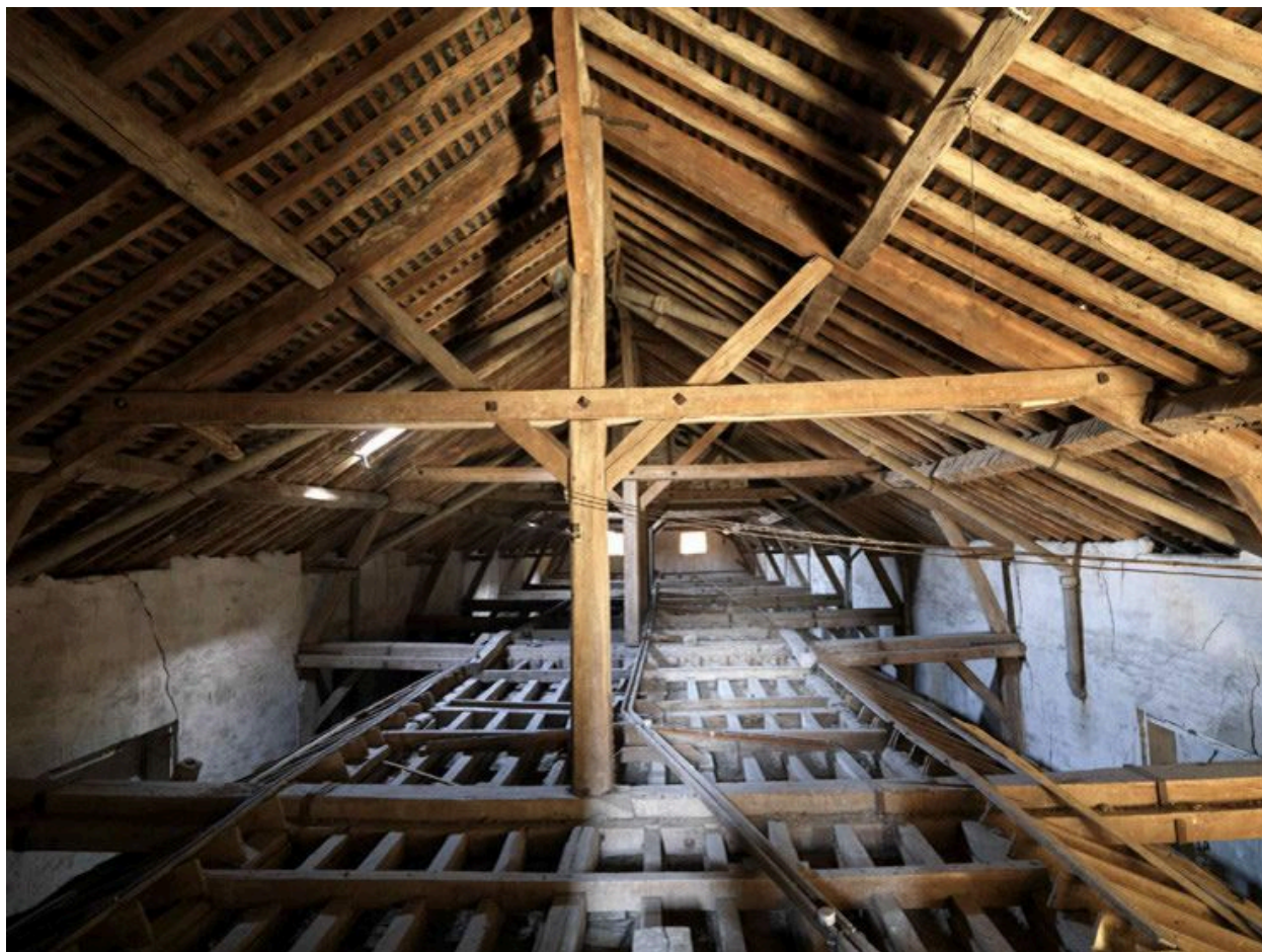
La charpente de l'église : vue d'ensemble, depuis l'ouest.
