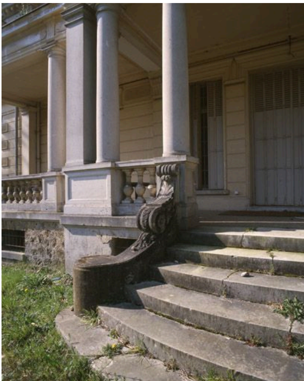
Détail du perron et de la loggia sur la façade arrière.
