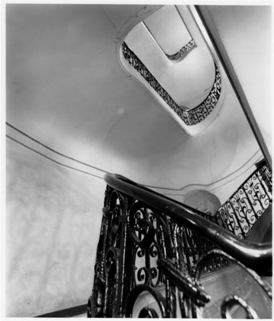
Vue de l'escalier en contre-plongée. Photographie, 2000. (Collection particulière. Photographies P. Sébert)
