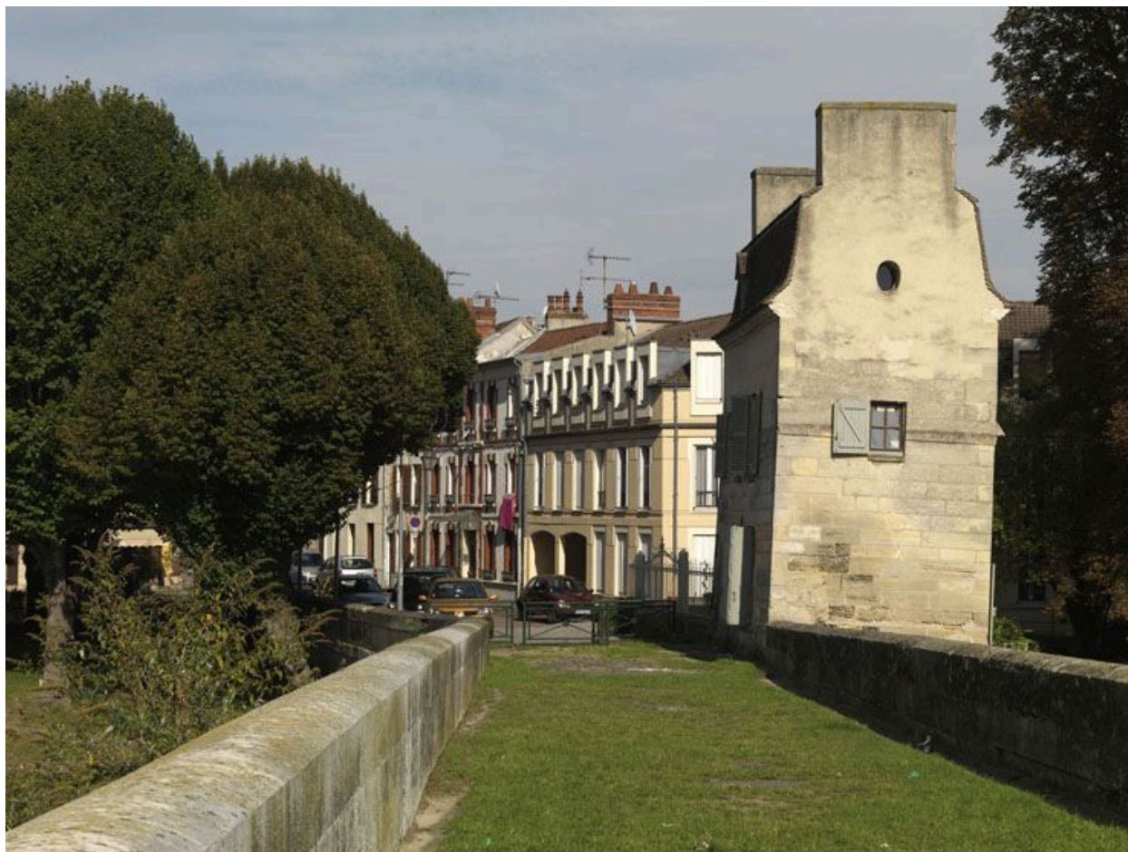
Chaussée du vieux pont de Limay bordée par les parapets, avec la maison du passeur en arrière-plan. La photo est prise juste avant l'interruption du pont.
