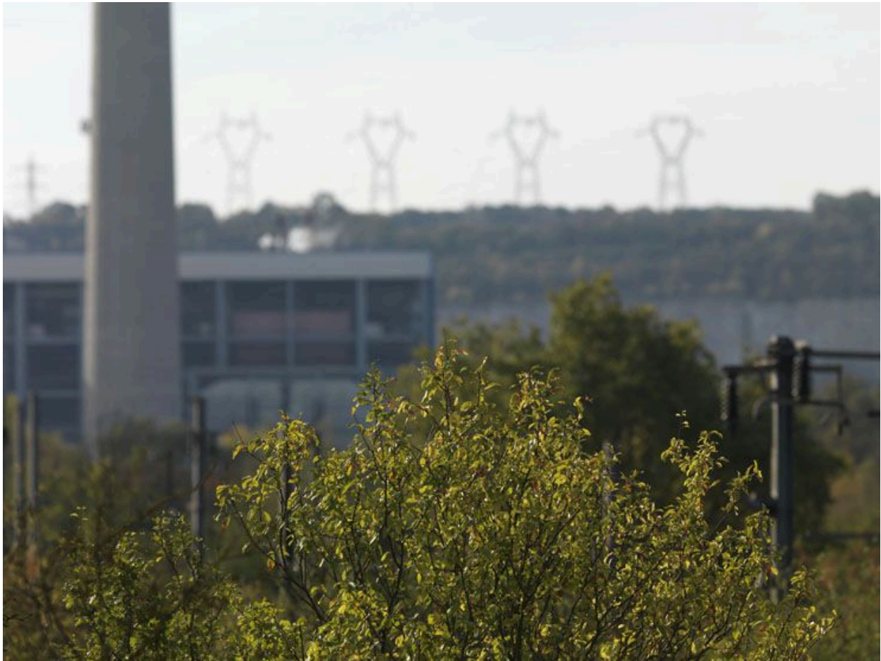
Porcheville : centrale électrique vue depuis la D 146.
