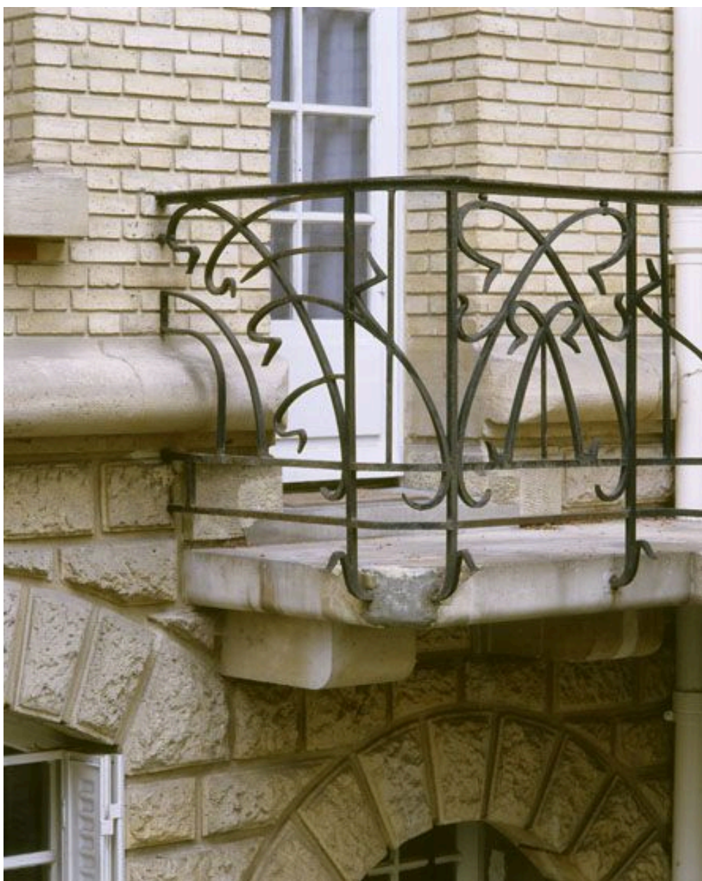
Détail des garde corps de style art nouveau.
