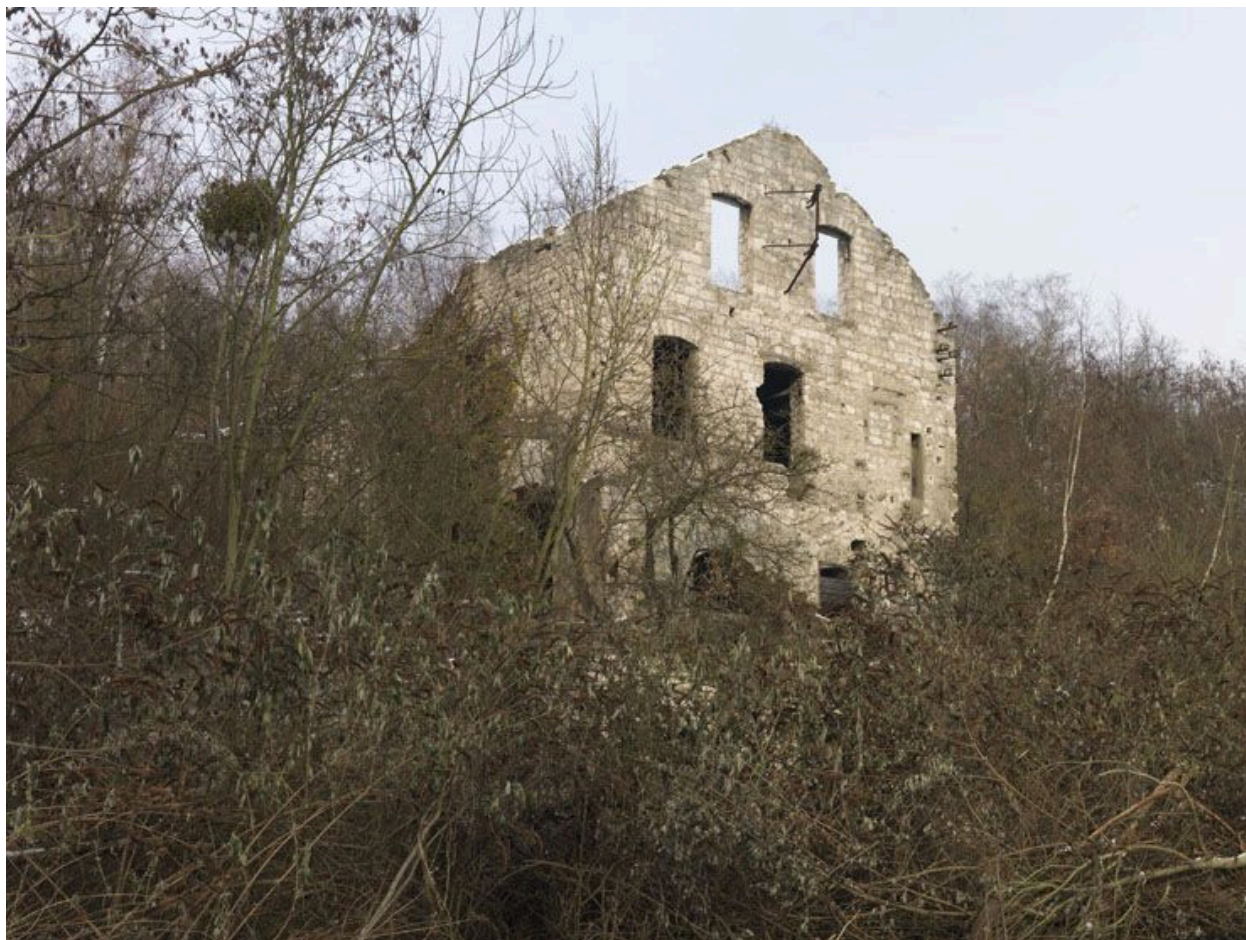
Follainville-Dennemont, cimenterie E. Candlot et Cie, puis A. Ladvocat et Cie, 44 rue Emile-Zola et rue Voltaire. Vestige d'un bâtiment ayant abrité des fours.
