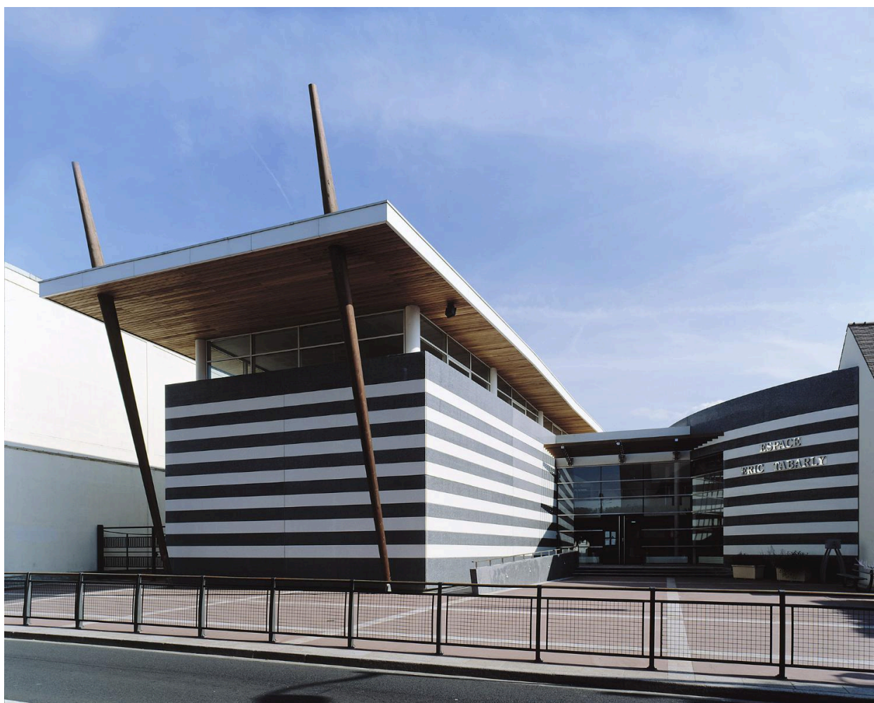
Vue d'ensemble sur l'avenue Paul-Vaillant-Couturier.
