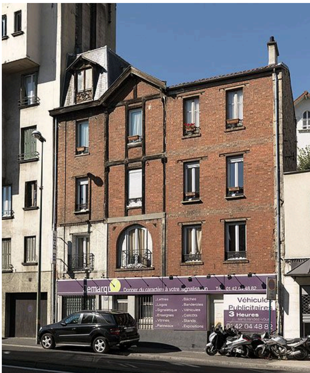
92, Suresnes, immeuble, 96 boulevard Henri-Sellier Façade en pan-de-bois hordé de brique.
