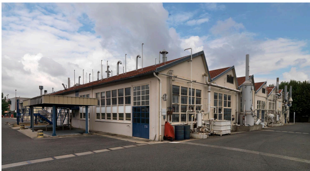
Site Biocitech, vue des bâtiments de production.
