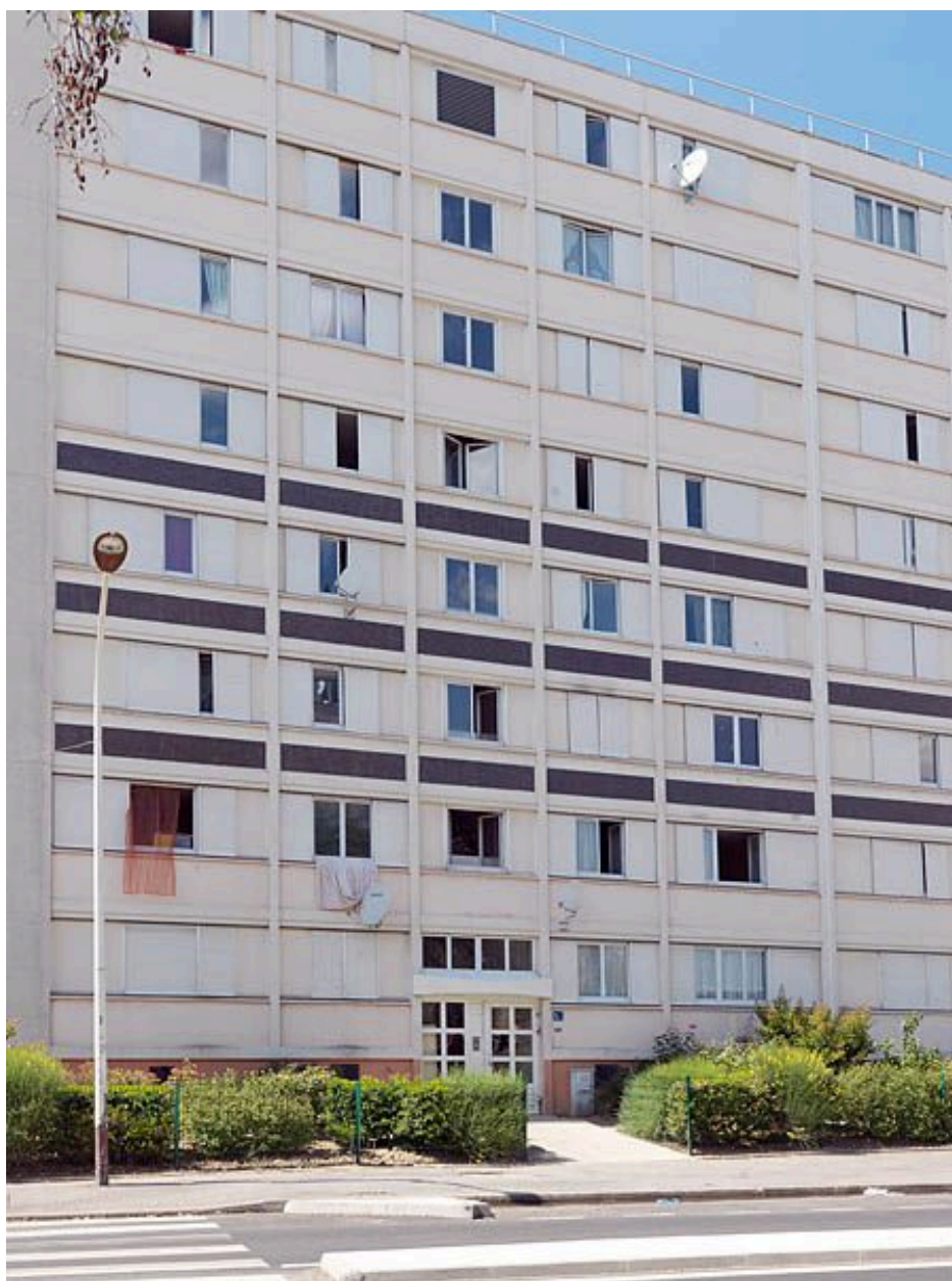
Cité dite Résidence Saint-Hubert. Entrée et façade partiellement rénovée d'une barre R+7.
