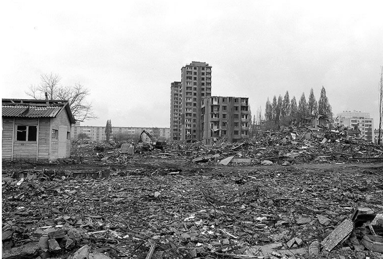
Tour 1, 2 et 3 (coin sud-est). Campagne photographique, lors de la destruction du bâtiment en 1976.
