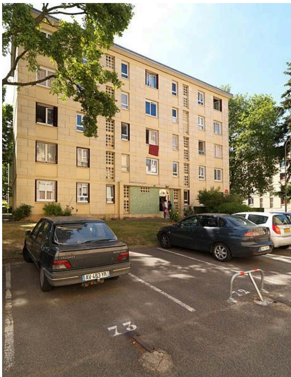
cité dite Résidence Les Fées. Bâtiment R+5 isolé.
