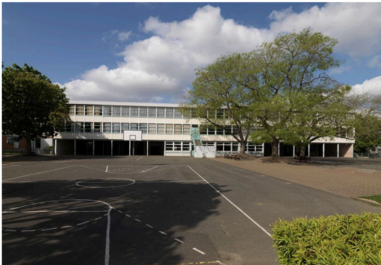
Groupe scolaire Descartes, allée de Champagne. Bâtiments et cour.
