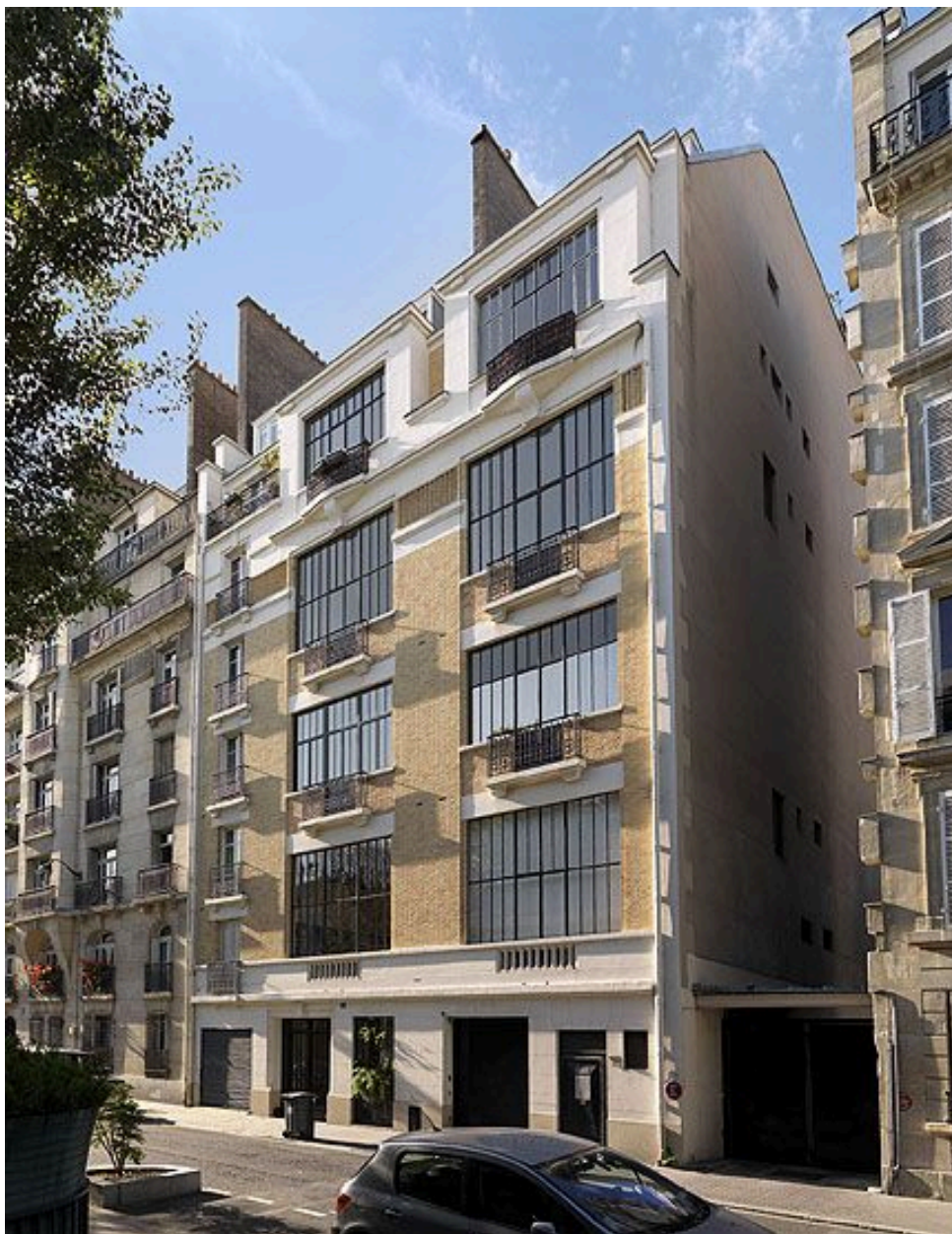
92, Neuilly-surSeine, immeuble, 63 rue Charles-Laffitte . Façade arrière de l'immeuble rassemblant les ateliers d'artistes.
