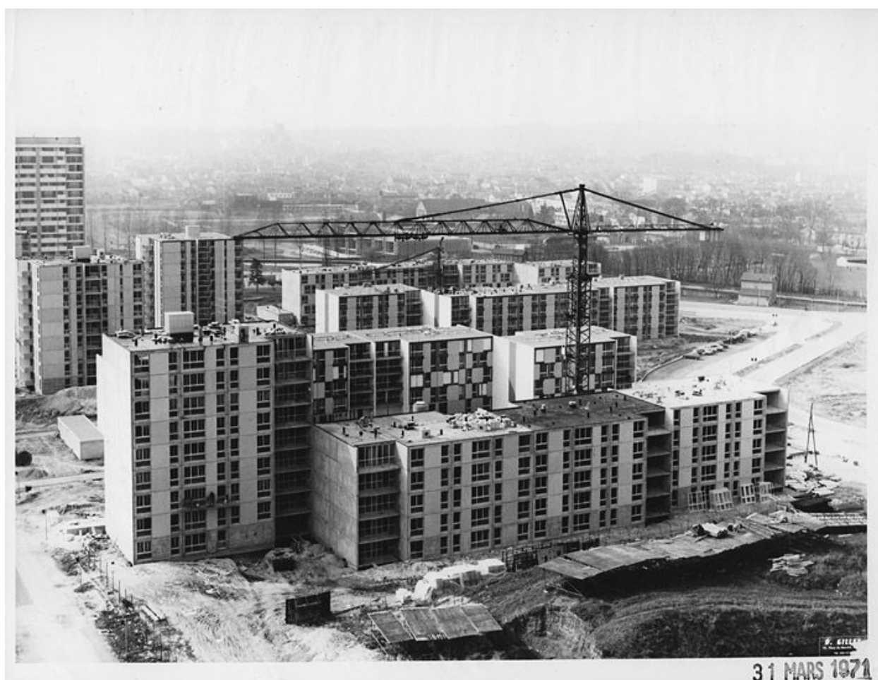
Vue de Beauval A depuis la tour Argonne. Au premier plan logements sociaux et au loin la tour Albret. Etat de progression du chantier. 31 mars 1971. (OPAC Meaux)
